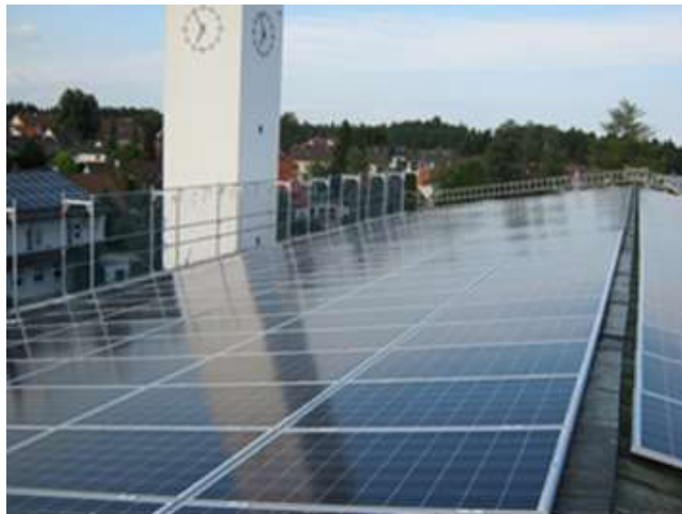
Photovoltaik-Anlage auf dem Dach der Kirche „Zu Unserer Lieben Frau von Wladimir“
